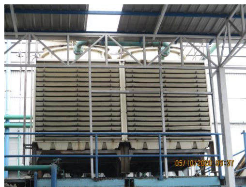
รูปที่ 11 หอระบายความร้อน (Cooling Tower)
